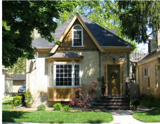
312 Hyman St.– Replacement Windows
