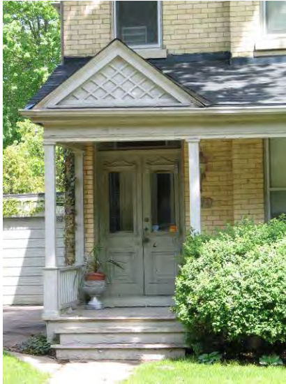
474 Maitland St. – Double Door Detail
