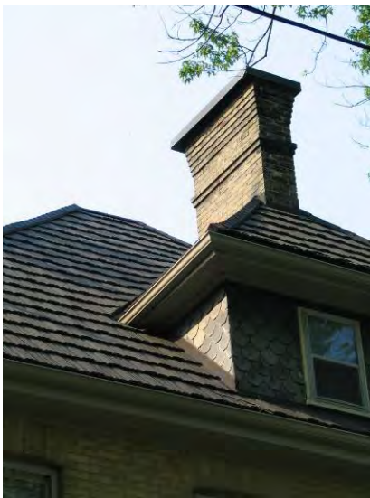
279 Hyman St.– Chimney detail
